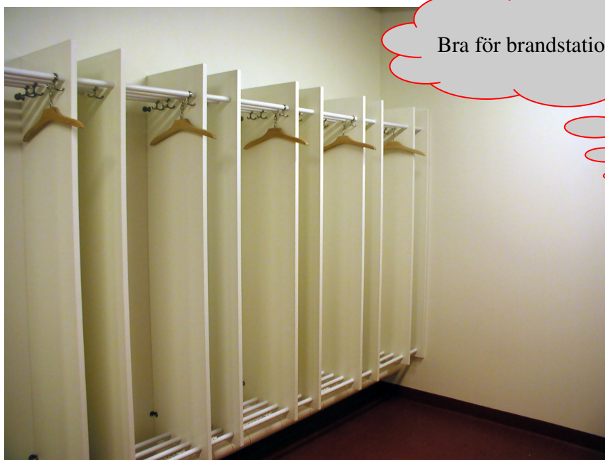
Bilden är från räddningsstationen i Nykvarn där varje brandman skall ett fack som är 500mm och ett fack som är 200mm. Det större facket har fasta galgar.
